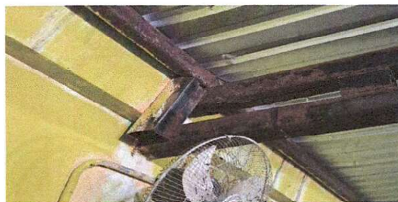
Foto 2: Se observa que la estructura de soporte de metal, necesita cambio total, ya que esta muy deteriorada.
