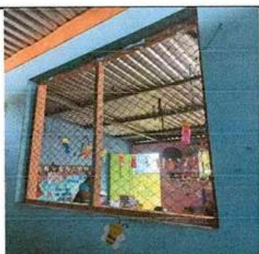
Foto 5: Ventana de Aula, Modulo 1
