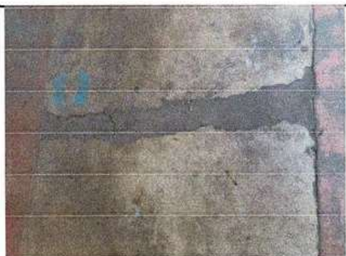
Foto 9: Piso de Aula, Modulo 1
