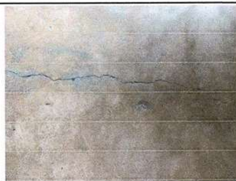
Foto 10: Piso de Aula, modulo 2
