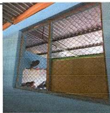
Foto 4: Ventana de Aula, Modulo 1
