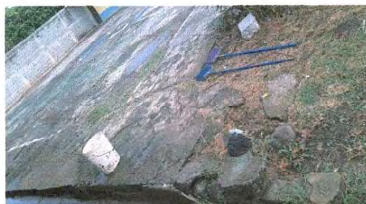
Foto 6: Se observa el mal estado la plancha de concreto de la cancha.
