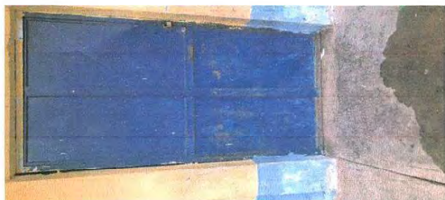
Foto 1: Se observa el mal estado de la puerta
