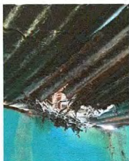
Foto 1: Se observa el mal estado de la lámina de la cocina
