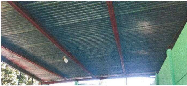
Foto 1: Se observa el mal estado de la lámina
