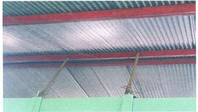
Foto 2: Se observa que la estructura de soporte de madera no es segura.
