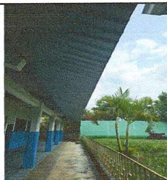
Foto 4: Instalacion de cuneta ya que en el invierno toda el agua cae y se moja el cemento, convirtiendola en una area resbalosa por el moho y peligroso para los niños
