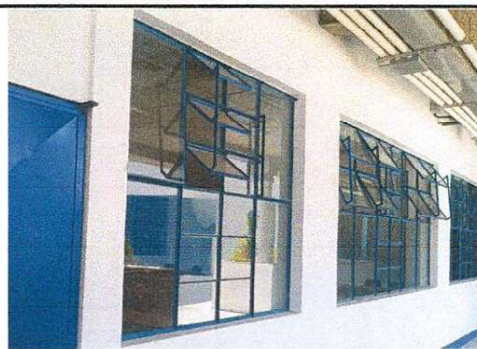
Foto 6: Se puede observar que las ventanas de la coordinación no son seguras, por lo que se requiere colocar balcon para brindar mayor seguridad.
