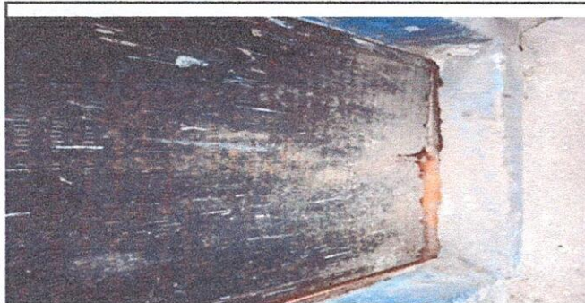
Foto #5. Se observa que la lámina de la puerta está en mal estado.
