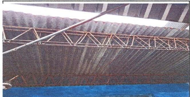
Foto #6. Se observa que hacen falta canales en las caídas de agua.
