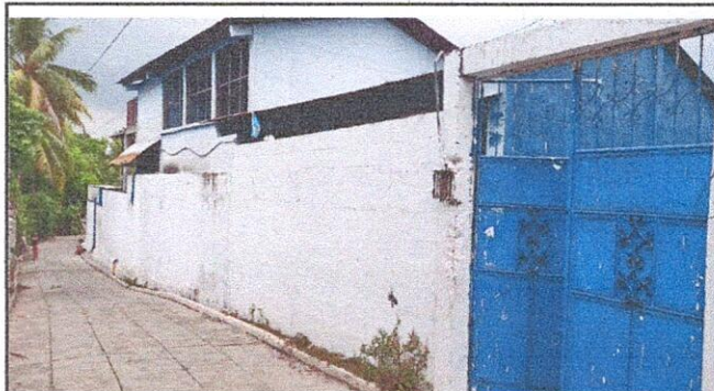
Foto #8: Se observa que en el muro perimetral hacen falta cuchillas de acero inoxidable. Reisor.
