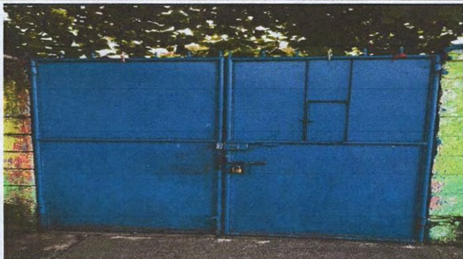
Foto 13: Se observa que el portón principal se encuentra oxidado sin mantenimiento ya que cuenta con mas de 25 años de uso.
