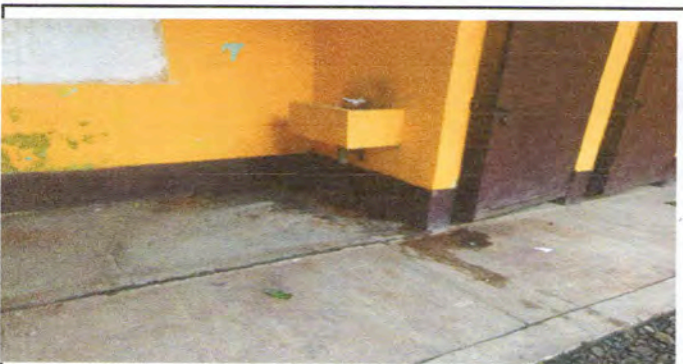
Foto 5: se llevara a cabo la remosion de la banqueta de los servicios sanitarios y se colocara una nueva.
