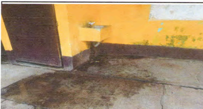
Foto 3: Se observa la necesidad de reparar los lavamanos, con sus accesorios..
