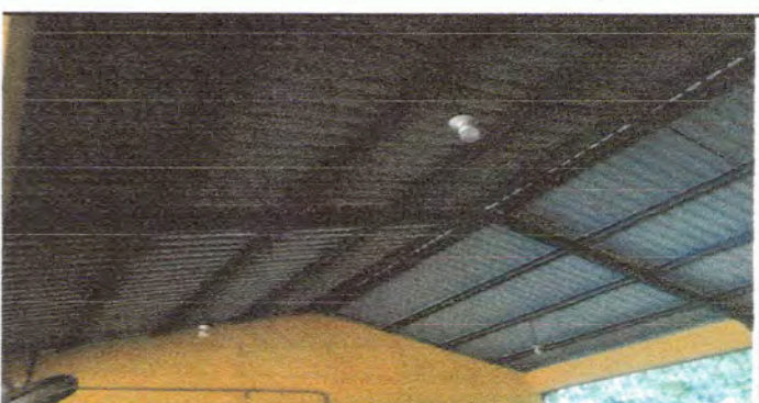
estructura de techo, se debe pintar todas las costaneras, y vigas para que tenga un tiempo largo de durabilidad
