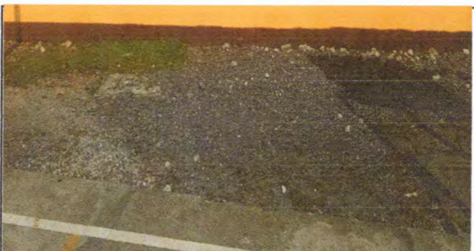
Foto 6: aca es necesario llevar a cabo la fundicion de una torta de cemento para darle uniformidad al trabajo
