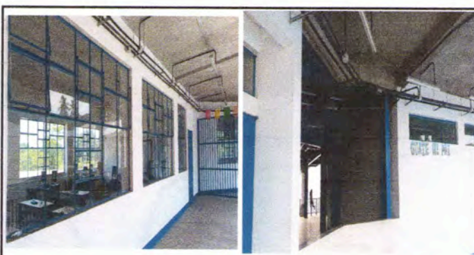
Foto 10: Se observa Suministro de balcones de metal en el Laboratorio de computación, bodega de computación, dirección, bodega general, sala de maestros, oficina de psicología, sala de espera de Psicología, visor al
