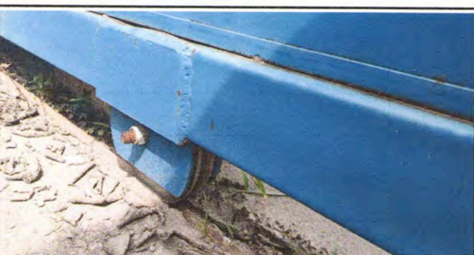
Foto 5: Se observa que se necesita sustitución e instalación de 4 rodos de 8 pulgadas a cada portón principal de la Escuela de La Reforma
