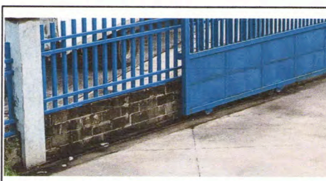
Foto 6: Se observa que falta Suministro de topes del portón principal. La Refora
