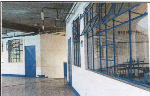
Foto 9: Se necesita Suministro de pintura latex a paredes de aulas, dirección, enfermería, baños docentes y alumnos, gradas y pasillos.
