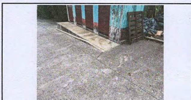
Foto 12: en esta posicion se dejara la llave de cheque, donde se colocara la caja de registro
