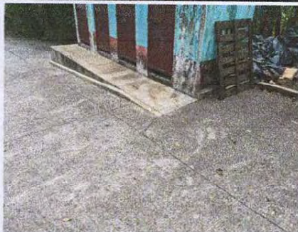
Foto 13: Se observa que la escuela no cuenta con llave de paso, pero la nueva llave se dejara junta a la caja de registro y el cheque
