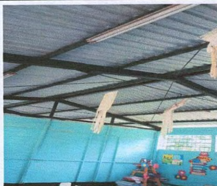
Foto 2: Se observa que la estructura de metal esta en mal estado, necesita mantenimiento.
