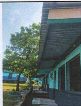
Foto 5: Se observa que la lamina existente no tiene canal para recepcionar agua de la lluvia.
