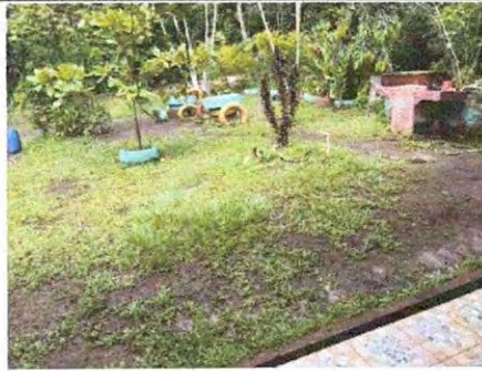
Foto 1: Es urgente el mejorar el acceso a la escuela, necesitamos una plancha de concreto.
