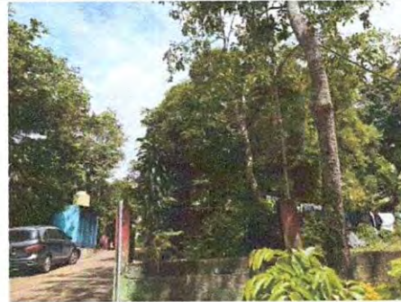
Foto 2: Se observa un alto peligro con el cableado de electricidad, urge cambiarlo.
