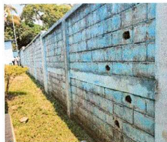
Foto 6: Se observa el deterioro de la pintura en el muro perimetral.
