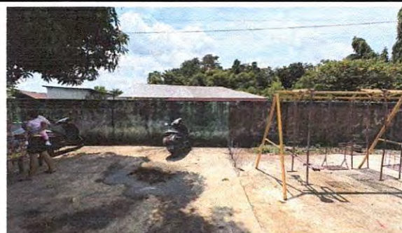
Foto 6: Se observa que no cuenta con razor el muro.
