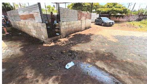
Foto 3: Se observa que en el caminamiento a realizar se colocará piso.
