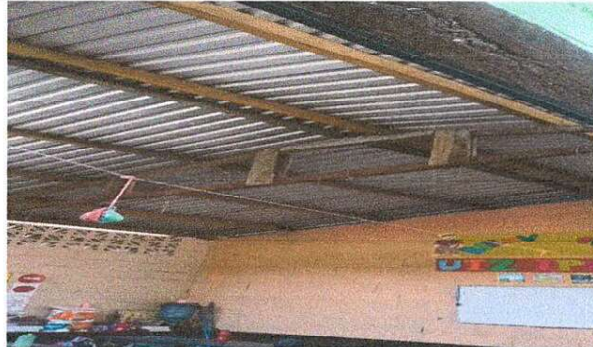
Foto 2: Se observa que la estructura de soporte se encuentra en malas condiciones por lo cual se necesita sustituirlo.
