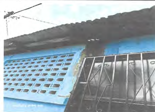
Foto 4: Se observa la necesidad de sustituir la estructura de madera por metal.
