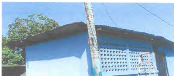
Foto 1: Se observa la necesidad de sustituir la lámina.
