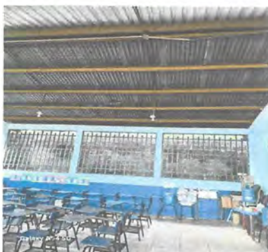
Foto 3: Se observa la necesidad de sustituir la lámina.
