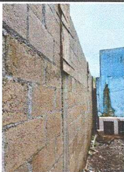
Foto 11: Se observa que el muro perimetral cerca de los servicios sanitarios no cuenta con repello, por lo que se necesita que se le aplique. De igual manera se observa que no cuenta con cernido, y se le deberá aplicar luego del repello.
