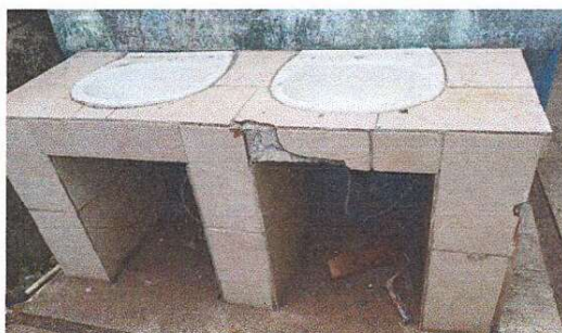
Foto 10: Se observa que la estación de lavado ya no es funcional y se desea sustituir por una estación de lavado de concreto y azulejo con 3 grifos.
