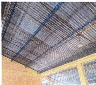
Foto 7: Se observa que la estructura de metal del modulo 3 necesita mantenimiento.
