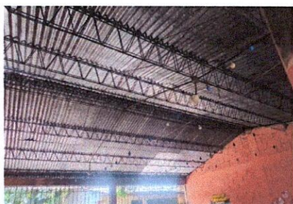
Foto 5: Se observa que la estructura de metal del modulo 2 necesita mantenimiento.
