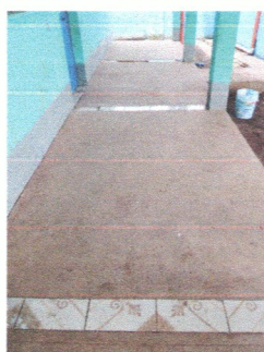
Foto 5: Se observa que el piso de los corredores son de torta de cemento por lo que es necesario sustituirlo por piso cerámico.
