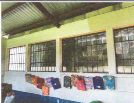
Foto 5: Se observa la necesidad de sustituir una hilada de block por protección
