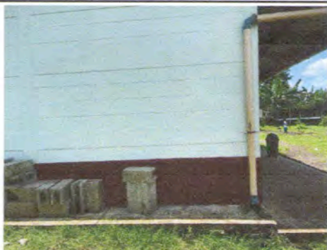
Foto 7: se observa la necesidad de colocar una estacion de lavado
