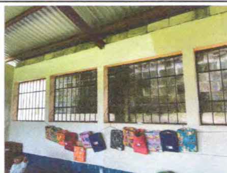
Foto 6: se observa la necesidad de repellar muro
