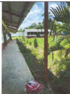
Foto 9: se observa la necesidad de instalar tubería en línea principal de agua
