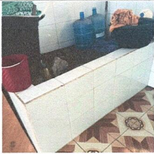
Foto 7: Se observa que la estufa no cuenta con ladrillos internos, por lo cual se suministrara el ladrillo para el cajón.
