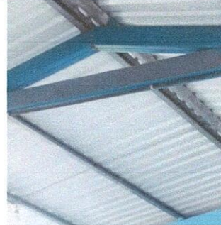
Foto 6: Se puede observar que el soporte metálico (costaneras) cuenta con desgaste, se aplicara lijado y pintura.
