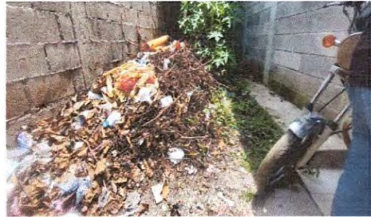
Foto 4: Se observa que se requiere colocar plancha de concreto para eliminar ese tiradero de basura.
