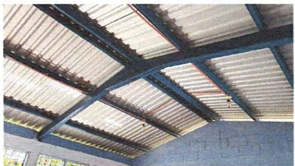
Foto 6: Se observa que se necesita mantenimiento de estructura soporte de metal.
