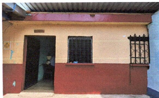
Foto 11: Se observa que la ventana de dirección es muy pequeña, por lo que no cuenta con suficiente iluminación y ventilación.
