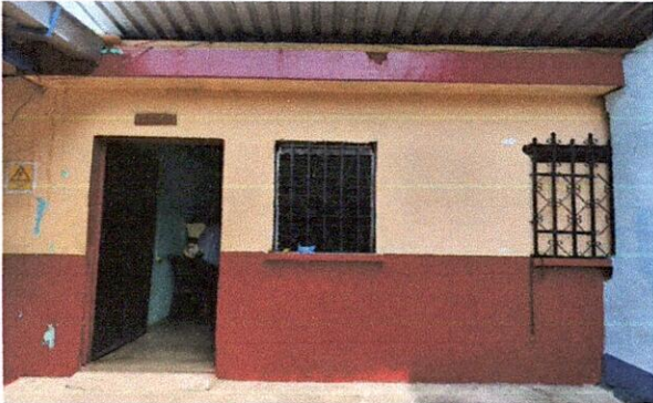
Foto 13: Se observa que se sustituirán los balcones porque se hará más grande la ventana.
