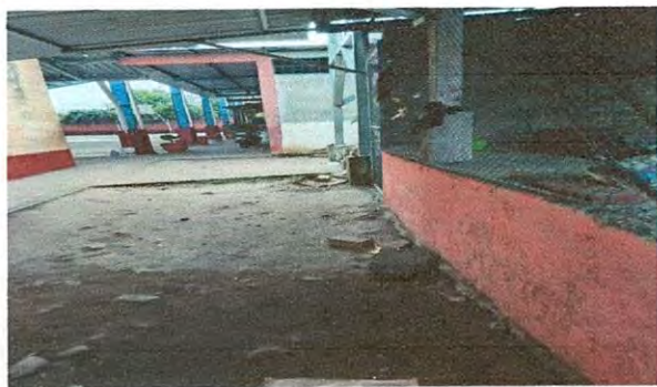
Foto 9: Se observa que se necesitara tubería PVC línea principal aguas negras para la estacion de lavado
