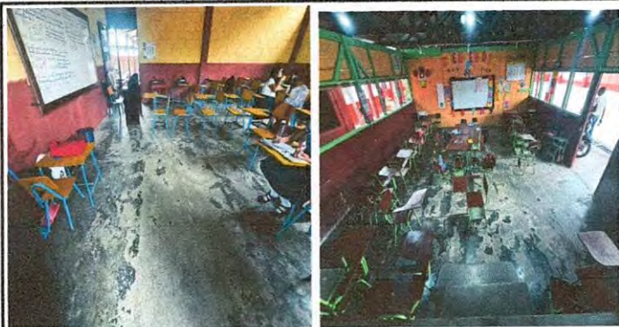
foto 11: Se observa que el piso es de concreto, por lo que se debera instalar piso ceramico en aulas de quinto, segundo y sexto primaria (Modulo 2)
