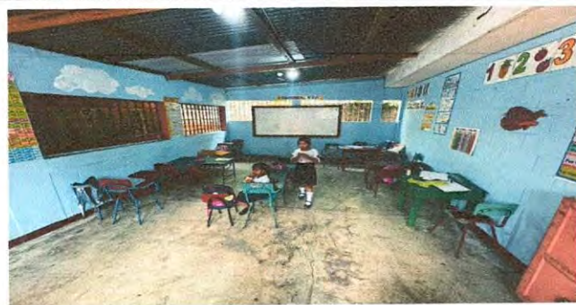
foto 12: Se observa que el piso es de concreto, por lo que se debera instalar piso ceramico en aula de cuarto primaria (Modulo 3)
