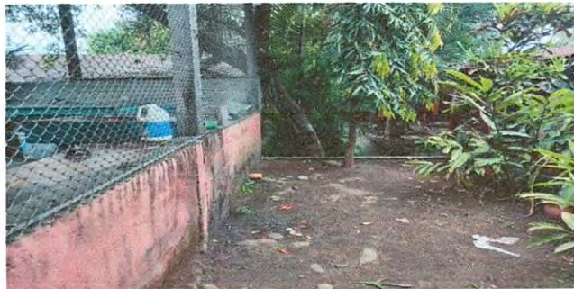
Foto 7: Se observa el sitio donde se instalara la estaciones de lavado de concreto y azulejo 2 m de longitud
