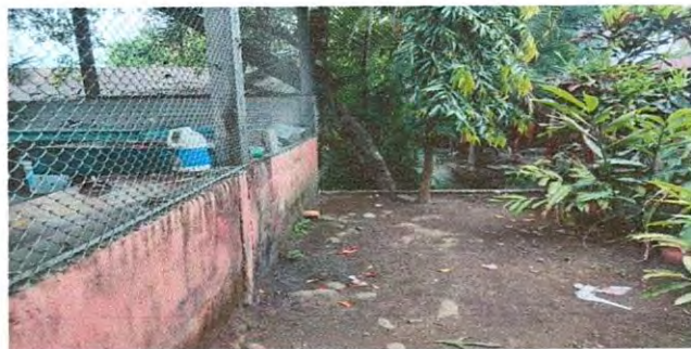
Foto 8: Se observa que no se cuenta con tubería principal de agua para la estacion de lavado que se suministrara, por lo que tambien se debera suministrar la tubería principal.
