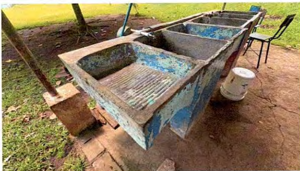
Foto 17: Se observa que una de las pilas se encuentra deteriorada.
