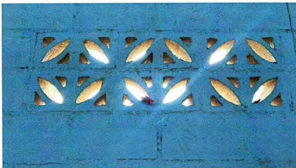
Foto 11: Se observa que se requiere ventana donde se abrirá el vano.
