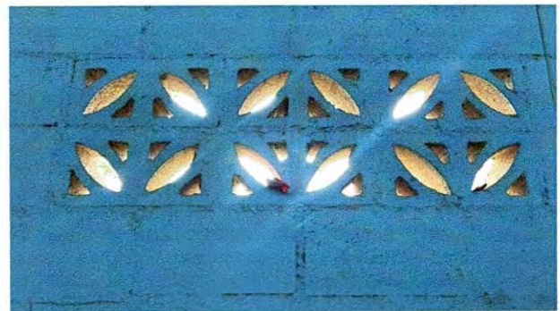
Foto 12: Se observa que se requiere balcones para la seguridad donde se abrirá el vano.
