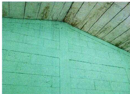
Foto 1: Se puede observar el deterioro de la pintura en las paredes y techos.
