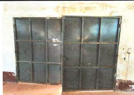
Foto 6: Se observa que el porton esta muy dañado, con los tubos oxidados, las bisagras rotas y en malas condiciones, debe ser sustituido.
