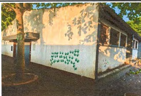
Foto 5: Se observan manchas y deterioro en la pintura del salón de usos múltiples, por lo que se deberá aplicar pintura nueva.
