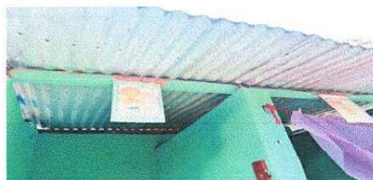
Foto 2: Se observa que la estructura de soporte de madera esta deteriorado y necesita cambio
