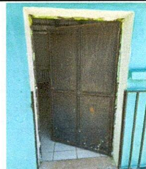
Foto 6: Se observa el deterioro e inicio en la oxidación de la puerta por lo que se le deberá brindar mantenimiento.
