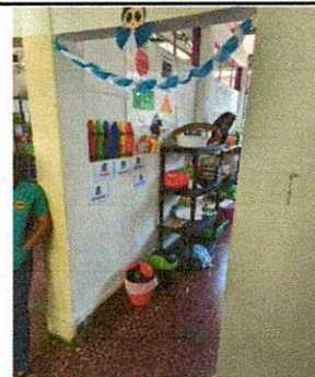
Foto 4: Se observa que no se cuenta con puerta, por lo que se deberá proporcionar una puerta de reja que permita la ventilación y que se puedan observar a los niños.
