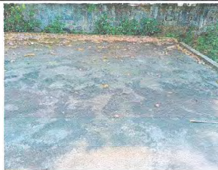
Foto 2: Se puede observar que la mayor parte del techo presenta deterioro, por lo que es necesario arreglarlo e impermeabilizarlo.
