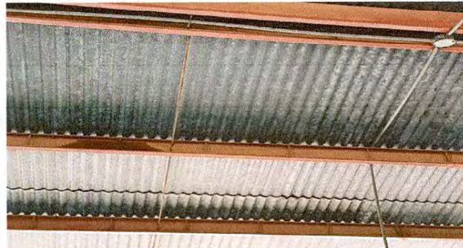
Foto 2: Se observa que la estructura de soporte de metal, necesita mantenimiento.
