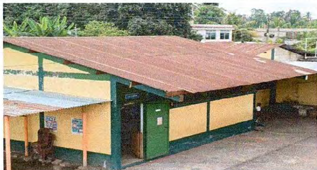
Foto 1: Se observa el mal estado de las láminas, lo que provoca que caiga agua en los salones de clases en tiempo de invierno
