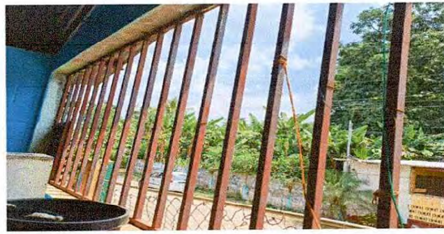
Foto 6: Se observa que los balcones ya cuentan con oxidó, es necesario darles mantenimiento.
