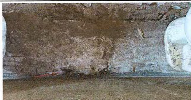
Foto 12: Se observa que los pisos se arruinaron totalmente, por lo que se debe suministrar una base granular para nivelación. A su vez se observa que en este se instalarán pisos cerámicos nuevos.
