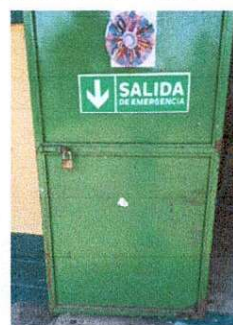
Foto 6: Se observa que la puerta se esta iniciando a oxidar y a deteriorar, necesita mantenimiento.
