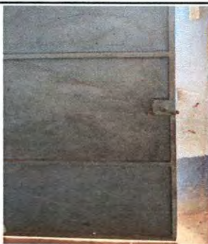
Foto 5: SE OBSERVA LA CHAPÁ EN MAL ESTADO, SE NECESITA SE CAMBIE.
