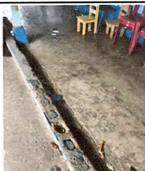
Foto 5: Se observa la existencia de una banqueta que impide el ingreso de agua, esta presenta daños por lo que debiera ser tallada.
