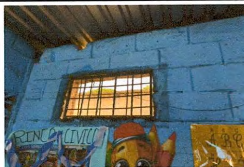
Foto 4: Se observa que se carece de ventana y el vano no se encuentra tallado.
