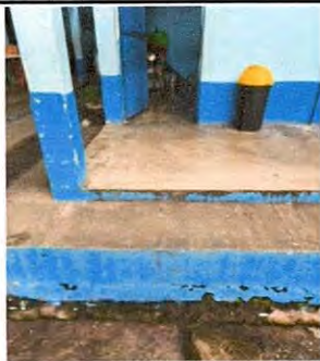
Foto 17: Se observa que la banqueta es muy alta por lo que deberá de contar con un grada para facilitar el acceso al módulo 3.
