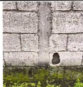
Foto 12: Se observa que el muro cuenta con múltiples agujeros, los cuales deberán ser resanados.
