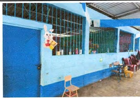
Foto 6: Se observa que la pintura en el frente e interior de las aulas esta manchada y envejecida por lo que se deberá renovar.
