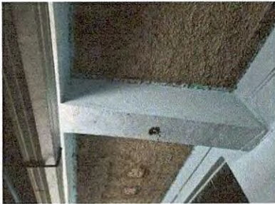
Foto 1: Se observa sistema eléctrico deficiente
