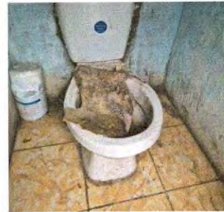
Foto 4: se observa falta de piso antideslizante
