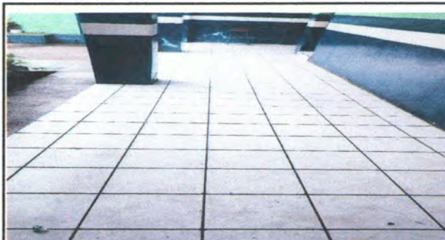
Foto 2: sustitucion de piso ceramico antideslizante .
