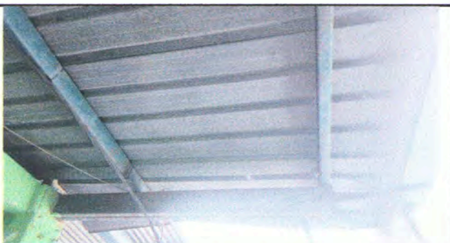
Foto 5: Sustitucion de lamamina por lamina troquelada aluzic calibre 26 ( incluye capote , tornillos ,desmontaje y montaje.)
