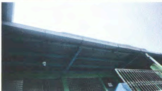
Foto 6: Suministro e instalaicon de canal metal.
