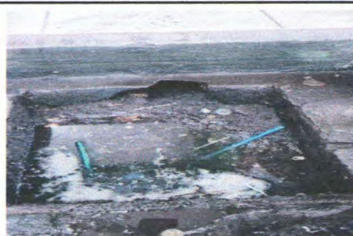
Foto 4: sustitucion de tuberia de liena tuberia de agua pluvial
