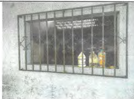
Foto 4: Se observa deterioro en los balcones y presencia de óxido
