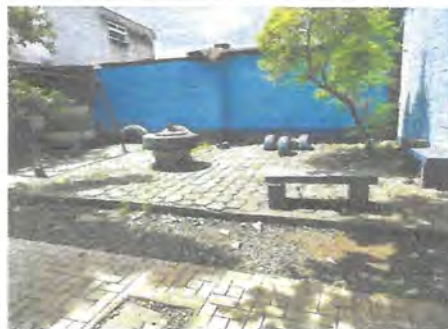
Foto 6: se observa la necesidad de la reparación del área de niño
