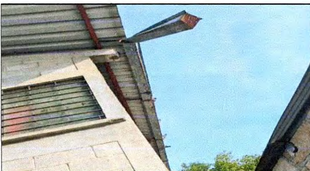
Foto 3: Sustitución de canal dañado.
