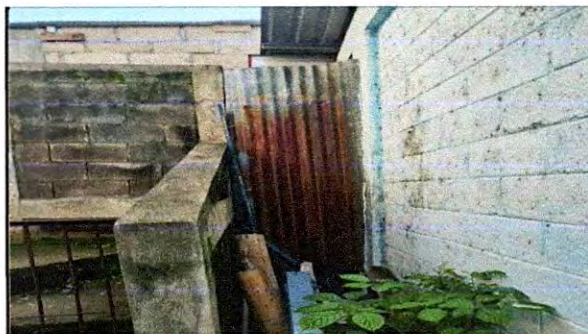
Foto 4: Colocación de barandas de metal en área de acceso
