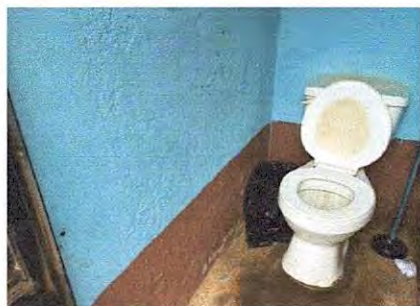
FOTO 13: Se observa falta de cerámico en interior sanitarios
