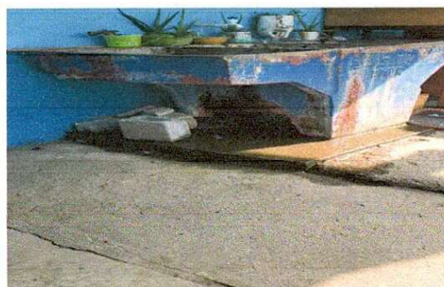
Foto 6: Se observa la pila en mal estado es necesario sustituirla
