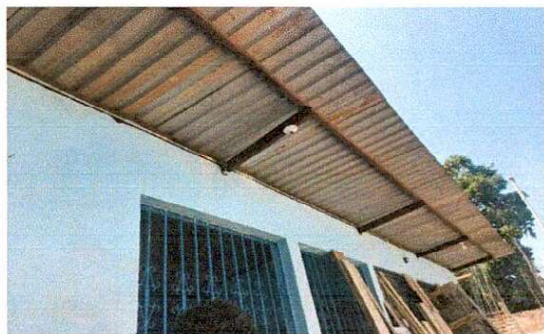
Foto 1: Se observa el mal estado de la lámina en el modulo de aulas 1.
