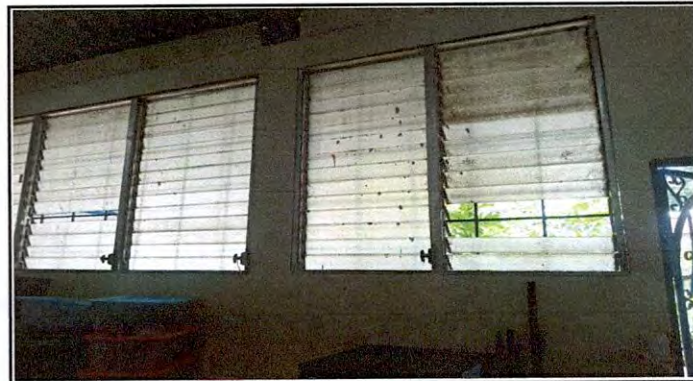
Foto 4: Se observa la necesidad de sustitución de ventanas de PVC.
