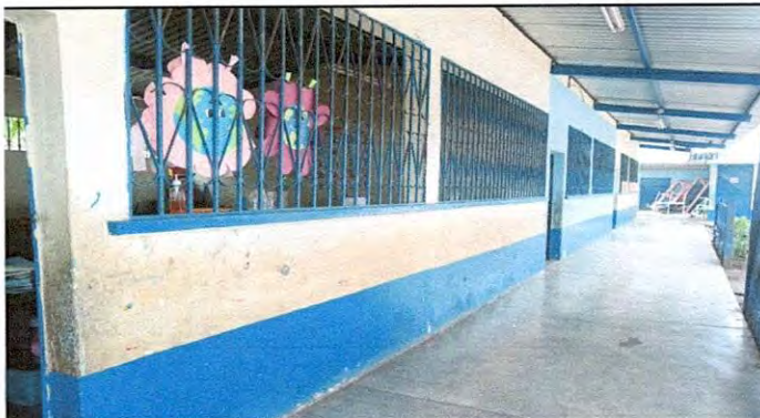
Foto 10: Se observa la necesidad de aplicar pintura latex acrilica anti hongos.
