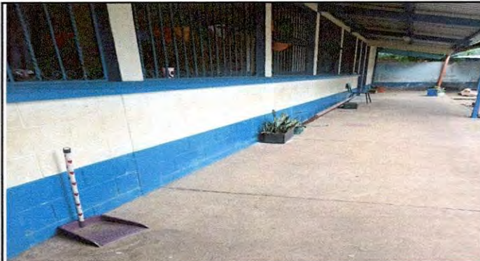
Foto 14: se observa la necesida de aplicar pintura latex acrilica anti hongos.
