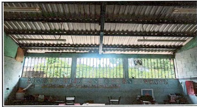
Foto 12: Se observa la necesidad de tapar con costanera la luz entre biga de corona y el techo.
