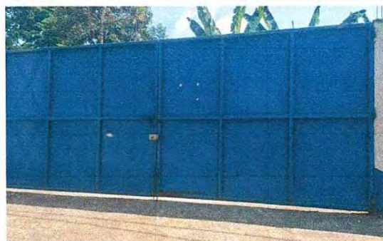
Foto 11: Se observa que el porton ya empieza a tener oxido y desgaste, ademas ya cuesta abrirlo, requiere mantenimiento.
