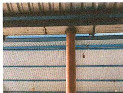
Foto 12: Se observa la canaleta en el modulo 3, esta no tiene la capacidad para captar toda el agua pluvial, se necesita una de mayor capacidad. También las caídas de agua ya no funcionan se sale el agua y se inunda la cancha.
