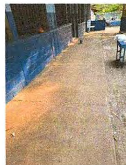
Foto 18: Se observa que los corredores solo tienen torta de cemento. Se necesita suministrar piso cerámico.
