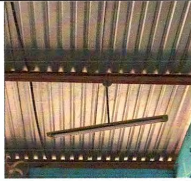
Foto 2: Se observa que el sistema eléctrico del módulo 1 no funciona y cuenta con cableado colgando y sin protección en algunas áreas por lo que deberá ser sustituido.
