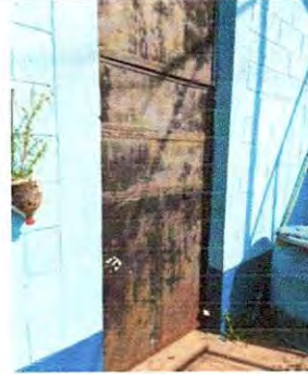
Foto 6: Se observa el mal estado de las puertas por lo que estas deberán ser sustituidas.
