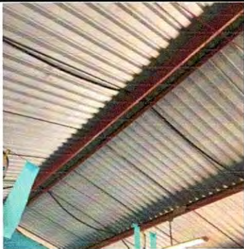
Foto 1: Se observa el deterioro de la estructura de soporte de metal del módulo 1 por lo que se le deberá brindar mantenimiento.
