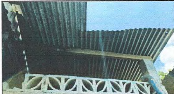
Foto 8: Se observa que la estructura de madera esta en mal estado por lo que urge la sustitucion por estructura de metal.
