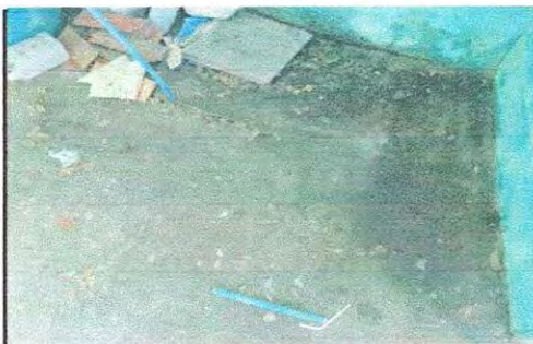
Foto 5: Se observa que el piso de concreto esta en mal estado, por lo que urge hacer el trabajo de nivelado y colocacion de torta de cemento.
