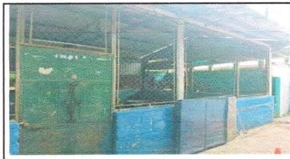
Foto 4: Se observa que la pared necesita aplicación de repello para proteger de la humedad-
