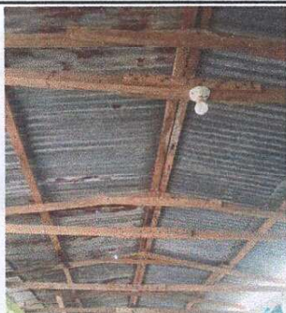
Foto 3: Se observa que la estructura de soporte de madera, necesita ser sustituida por metal
