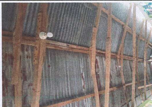
Foto 1: Se observa el mal estado de la lámina en el aula
