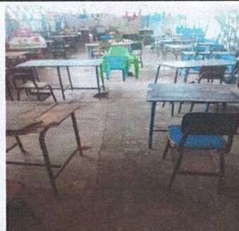
Foto 6: Se observa piso en mal estado, interior aula, sera reparado por torta de concreto 5cm de espesor
