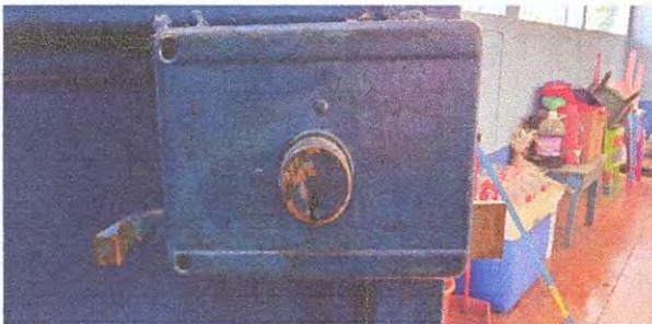
Foto 3: SE OBSERVA LA CHAPA EN MAL ESTADO, SE NECESITA SE CAMBIE.
