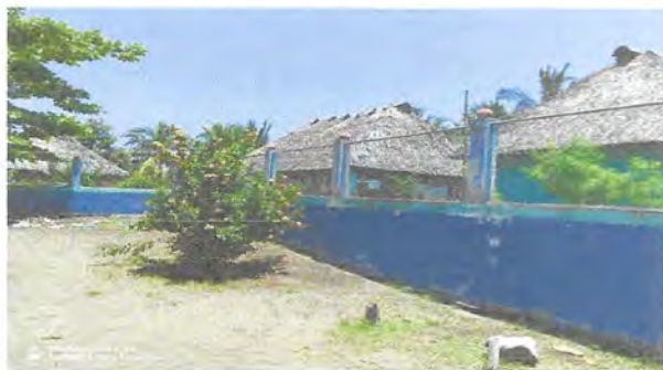
Foto 9: se observa que no hay existencia de bomba de agua y es necesario facilitar su uso.
