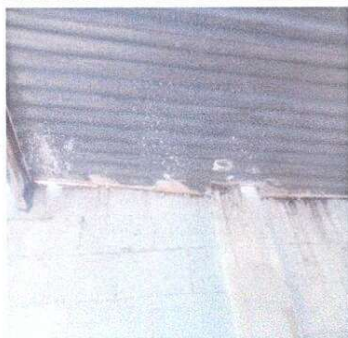
Foto 3: Se observa el mal estado de las laminas por la oxidación y picadura
