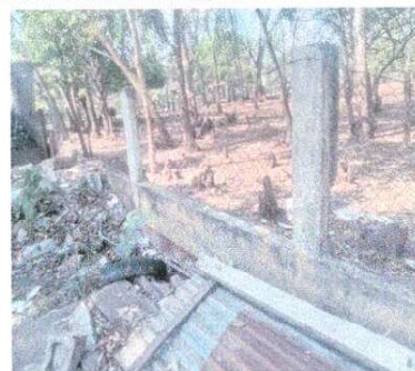
Foto 6: Se observa el mal estado del muro perimetral por lo que se necesita cambio de muro perimetral
