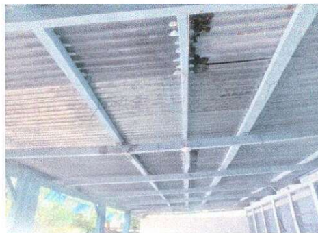
Foto 2: Se observa que la estructura de soporte de lamina necesita cambiar viga de madera por estructura de metal.
