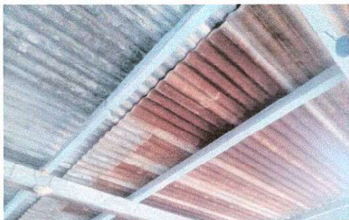
Foto 1: Se observa el mal estado de las laminas por la oxidación y picadura
